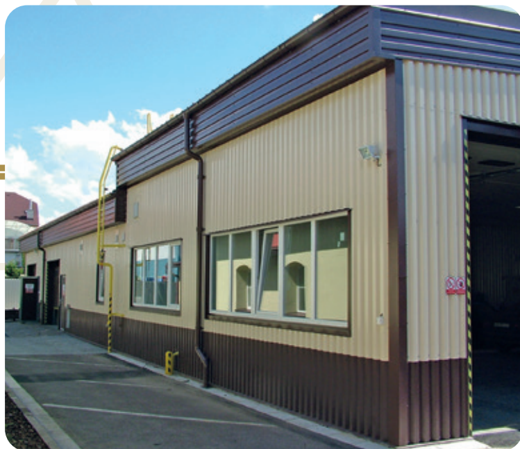
Nová montovaná hala postavená na místě původních starých budov
