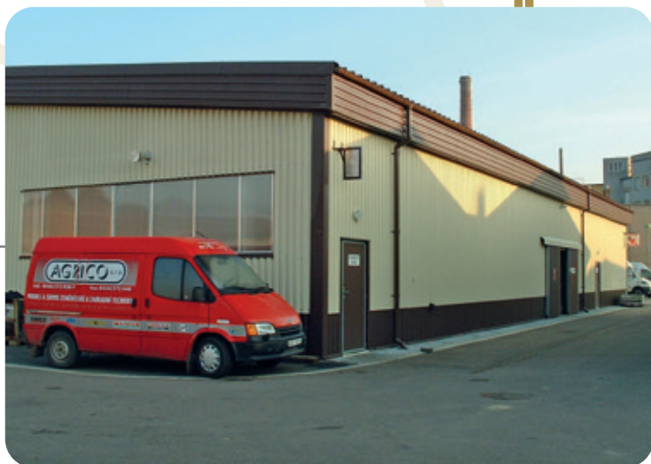
Nová skladovací a servisní hala
